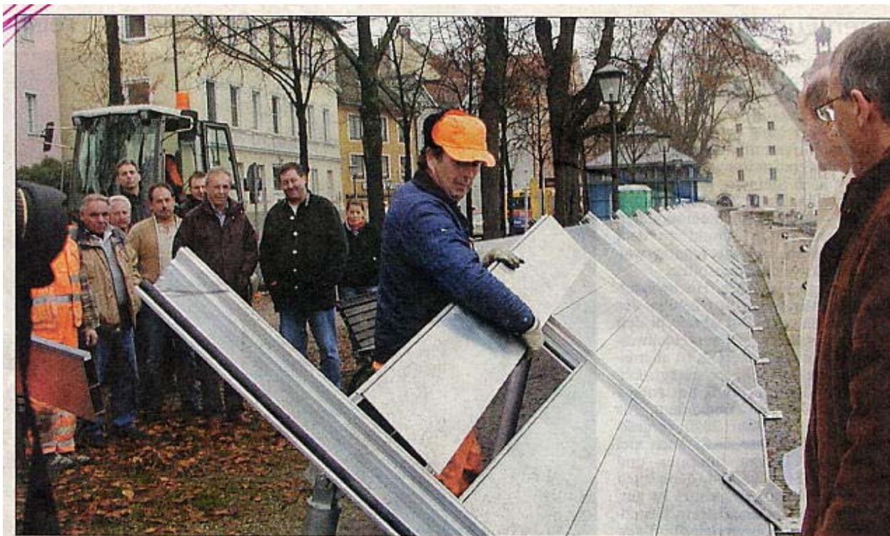
1,30 Meter hoch ist das neue Katastrophenschutzsystem, das gestern in der Thundorferstraße zur Probe aufgestellt wurde. Für 200 Meter Schutzlänge benötigten die acht Männer des Tiefbauamtes gut drei Stunden. Foto: Scherrer
