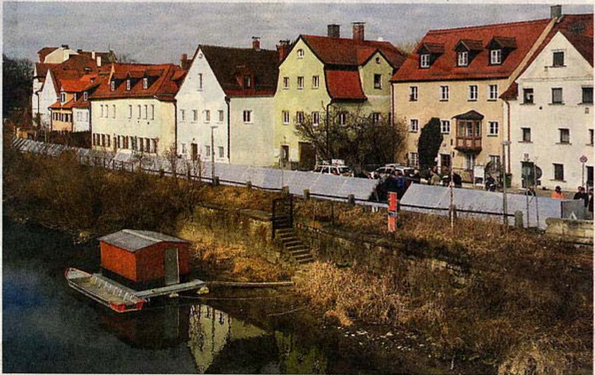
Die Badstraße war am Dienstag wasserdicht: Regensburg präsentierte seine neue Schutzwand. Foto: Peter Ferstl
