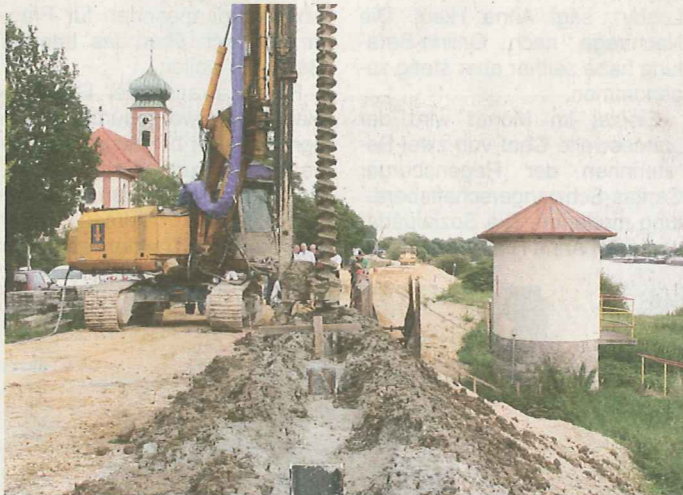
Mit dem MIP-Verfahren werden der Boden und eine Bindemittelsuspension erschütterungsarm vermörtelt. Foto: Reisenauer
