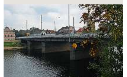
Der Ausbau und die Umgestaltung der Frankenstraße mit dem Neubau der Frankenbrücke sind auf 16 Millionen Euro veranschlagt. Im neuen Investitionsprogramm sind davon 12,5 Millionen enthalten.
