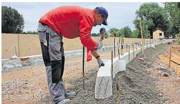
Uferstraße: Ein Arbeiter klopft die Begrenzungssteine fest.
