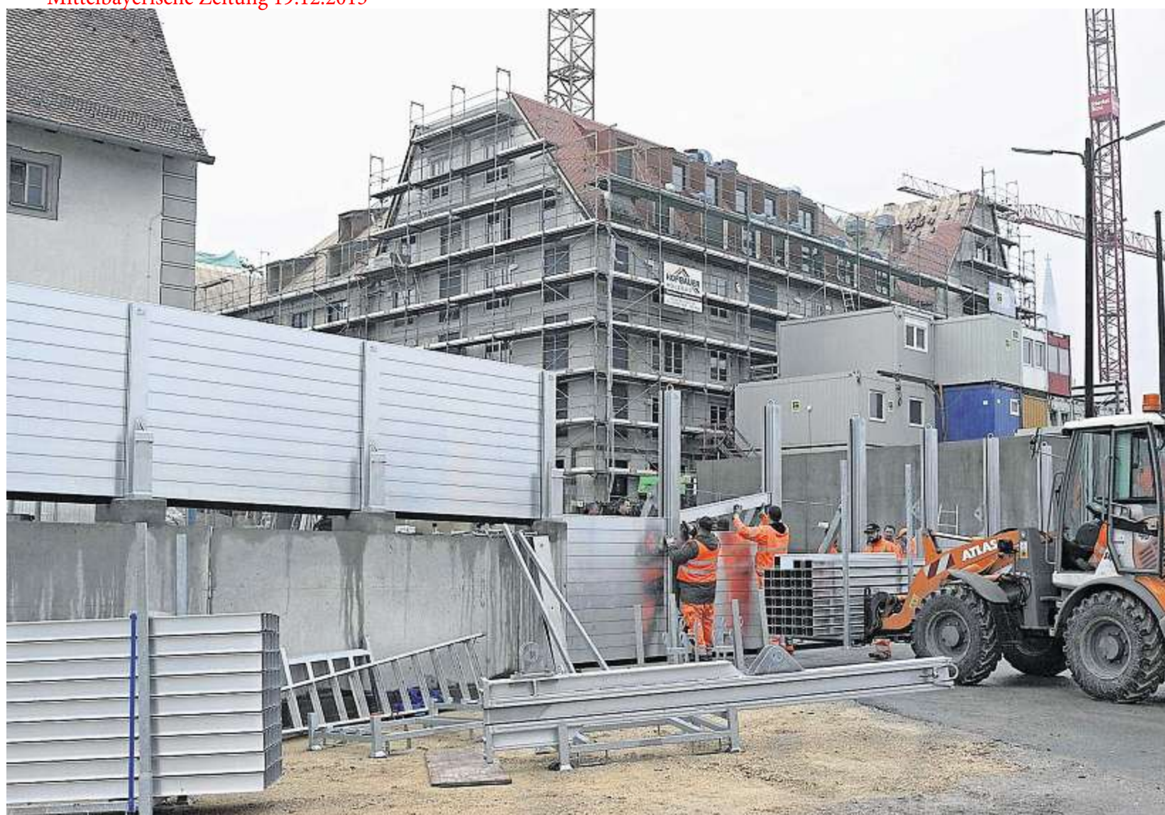
In trockenen Zeiten ist rechts eine Zufahrt: Im Hochwasserfall schützen mobile Elemente, hier im Testaufbau, die Häuser. Foto: Rolf Thym/Stadt Regensburg
