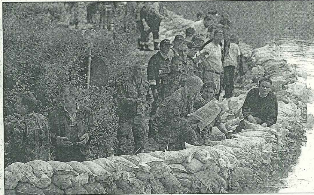
Erstmals in Regensburgs Hochwasser-Geschichte blieb in der vergangenen Woche die Wassergasse trocken. Im Herbst wird ein mobiler Hochwasserschutz angeschafft, der die Sandsäcke ersetzt.
