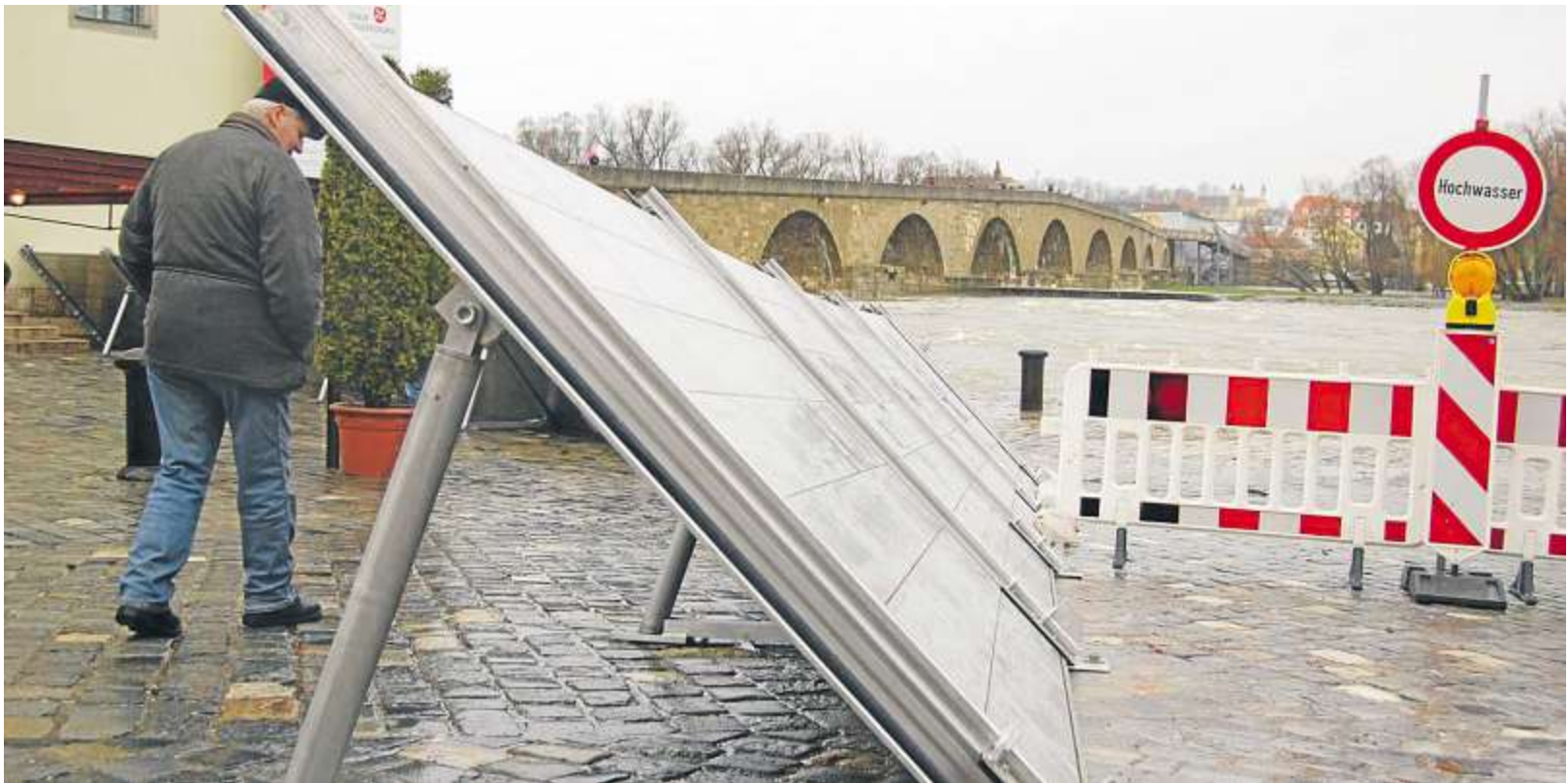
Der mobile Hochwasserschutz an der Wurstkuchl ist aufgebaut, doch die Donau hielt sich gestern noch in respektvollem Abstand zu der metallenen Wand und blieb im Bett. Foto: Klein
