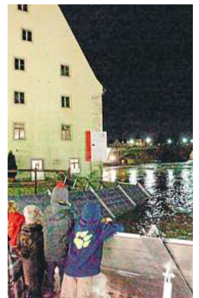
Am Freitagabend machte sich das Wasser an die Schutzwand heran.
