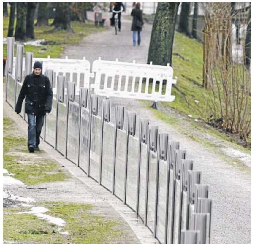
Gut vorbereitet: An der Dammkrone in Stadtamhof, Richtung Grieser Weg, wurden präventiv erste Absperungen errichtet.
