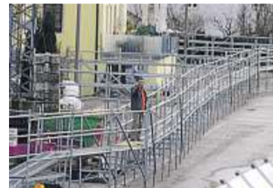
An der Werftstraße errichteten Helfer extra einen Fußgängersteg.
