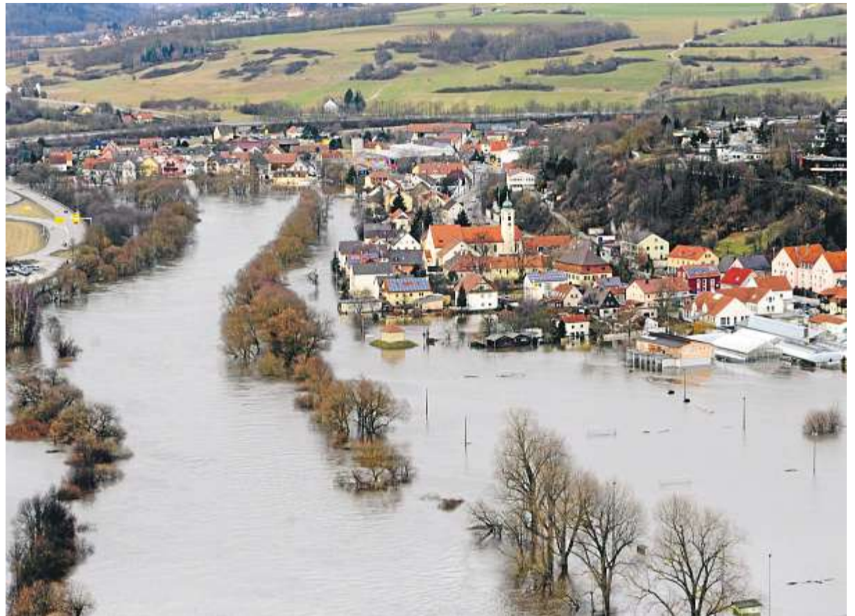
Im Stadtteil Sallern trat der Regen über die Ufer und überflutete Straßen und Häuser.
