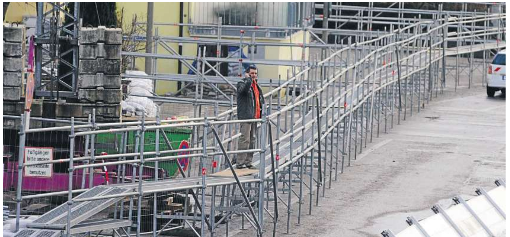
In manchen Uferbereichen waren umfangreiche Stegkonstruktionen erforderlich.
