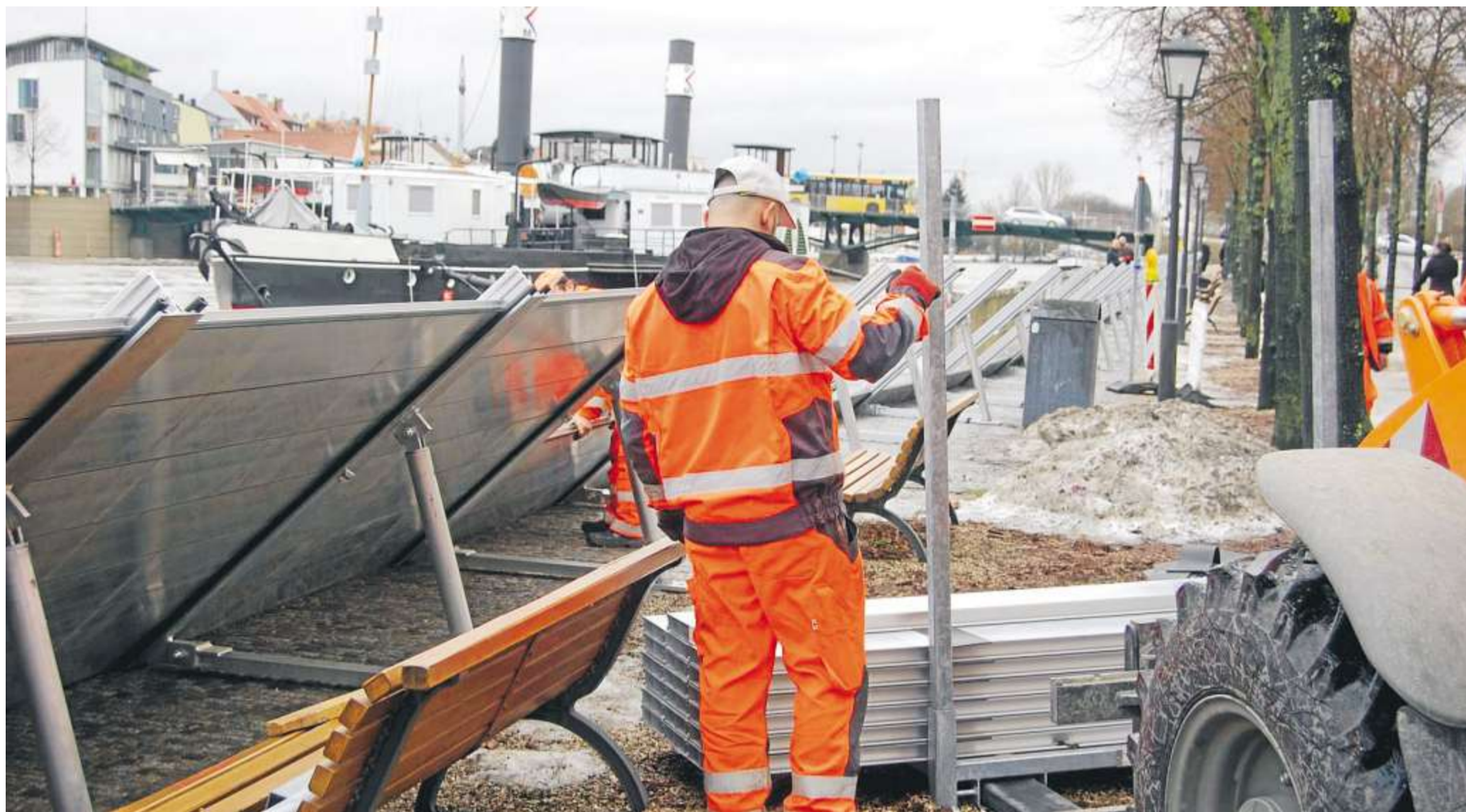
Ein Hoch auf das leichte aber starke Aluminium: Mitarbeiter der Stadt Regensburg bei der Montage der Flutschutz-Wände (hier an der Thundorfer Straße).
