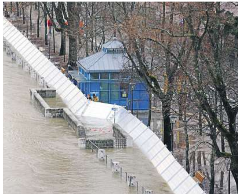
Die mobilen Elemente hielten den Wassermassen stand.
