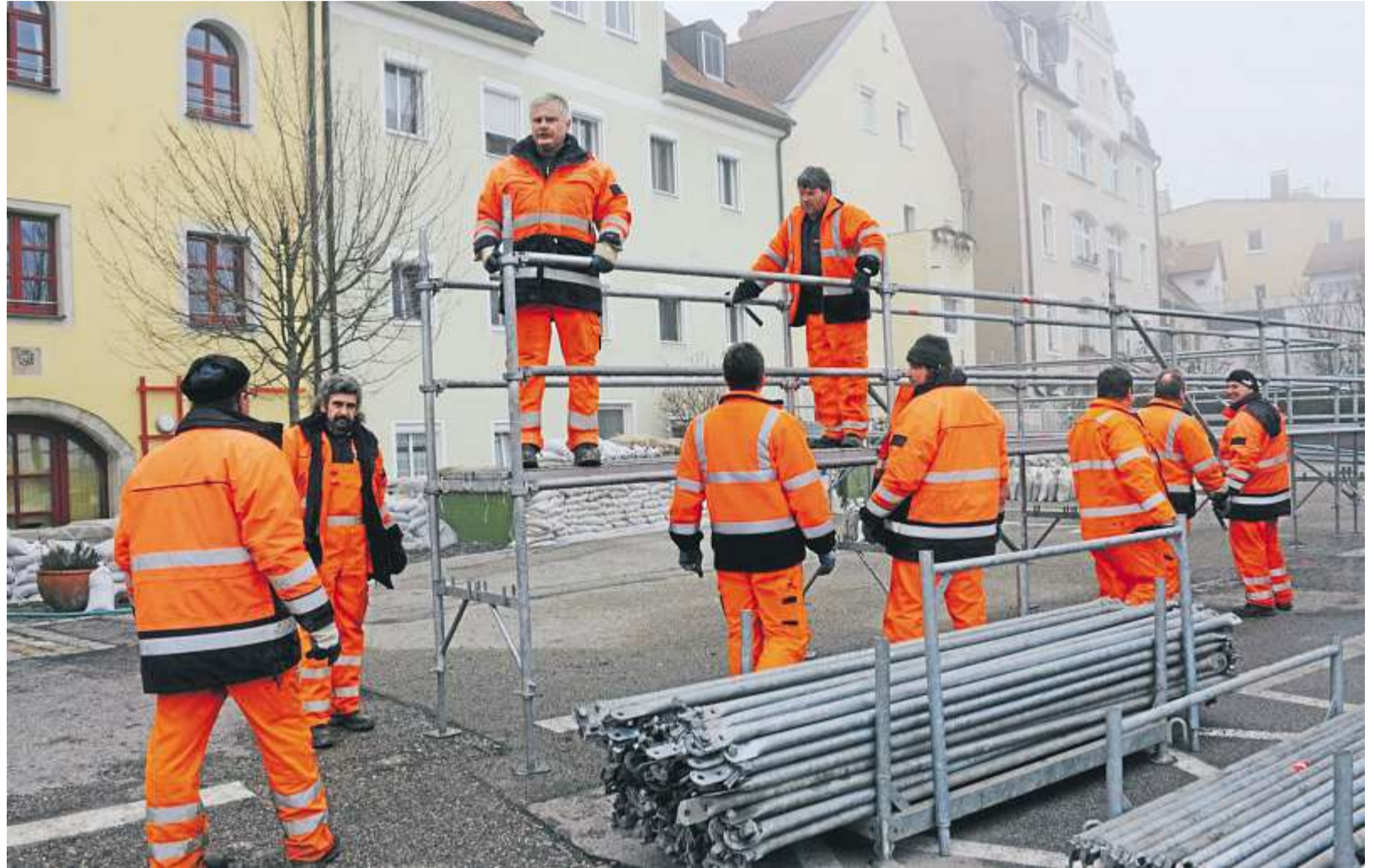
Das gut eingespielte Team des Tiefbauamts war gestern dabei, in der Werftstraße die mobilen Elemente und die Stege, die für die Fußgänger aufgebaut worden waren, zu beseitigen. Fotos: Lex
