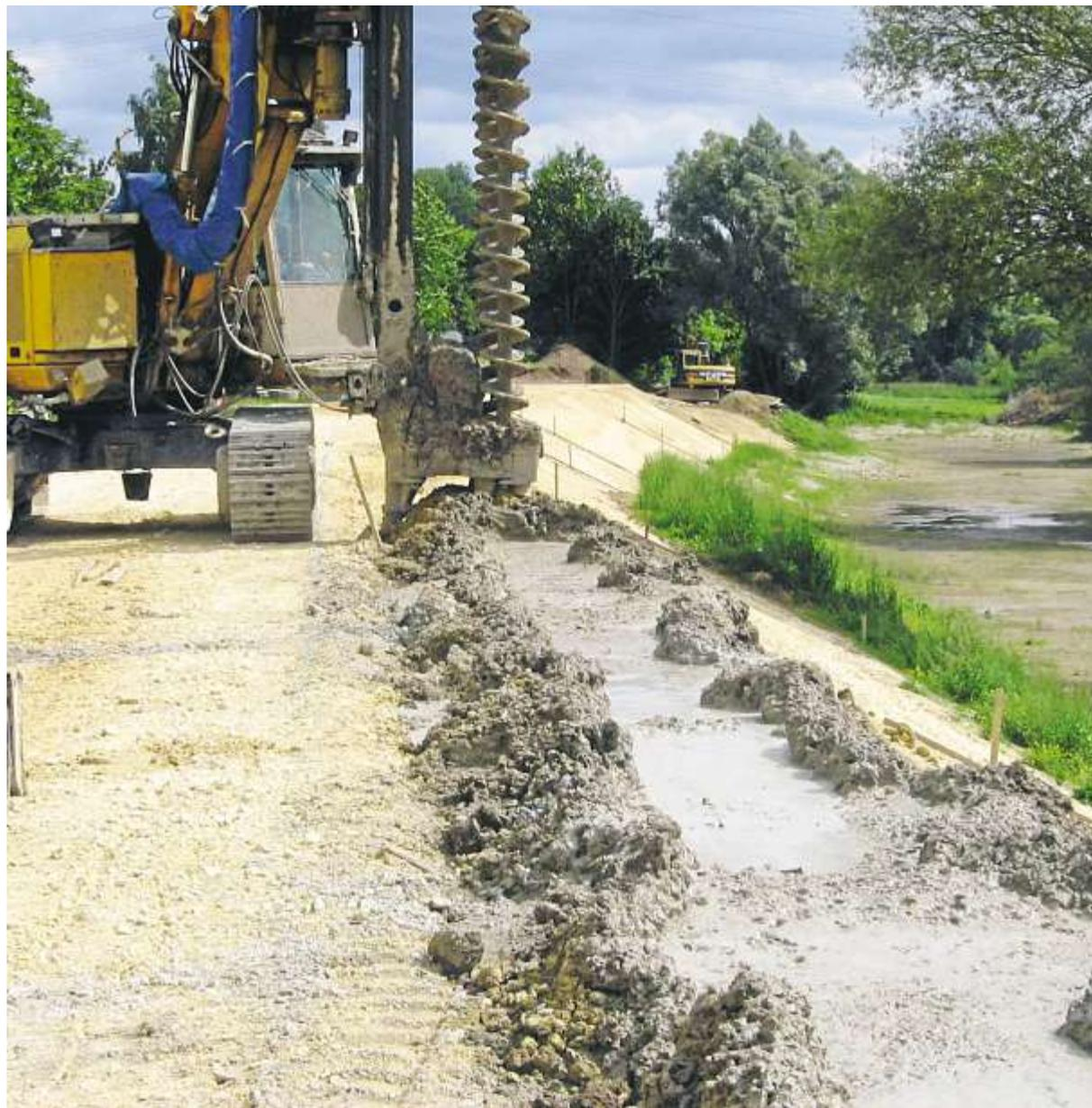
Der bestehende Hochwasserdamm wurde erhöht und bekam einen Betonkern.
