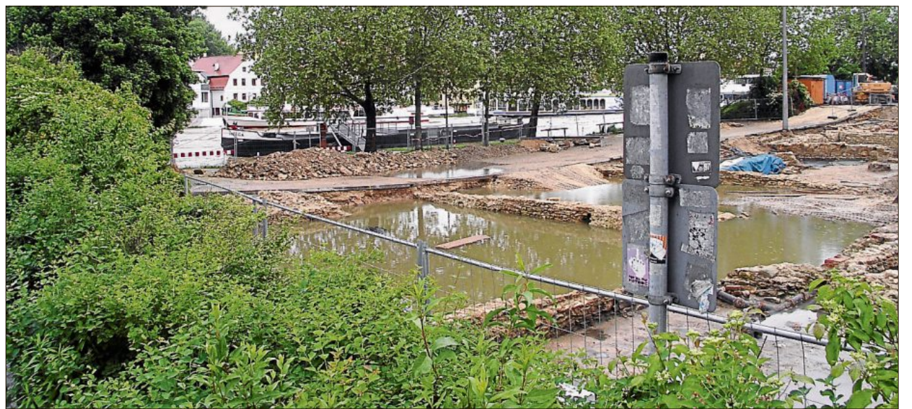
Die archäologische Ausgrabung am Donaumarkt, wo das Museum „Haus der Bayerischen Geschichte“ entstehen soll, läuft am Sonntagnachmittag mit Donauwasser voll, das durch den Uferboden sickert.
