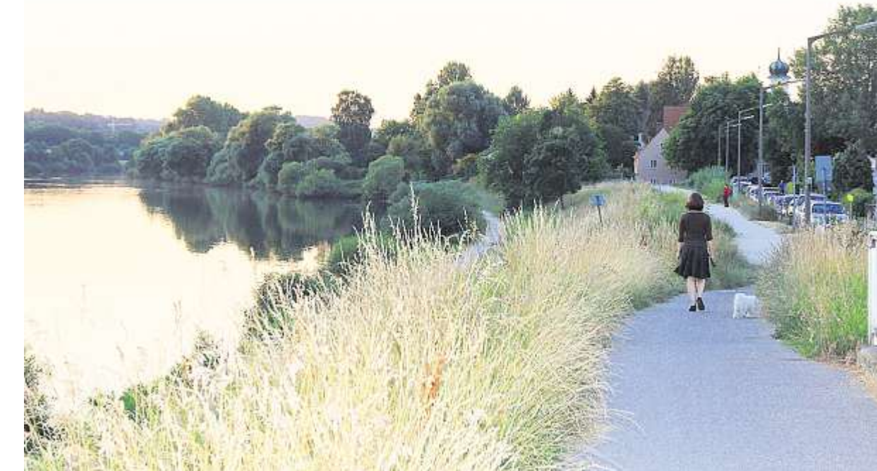
Das Ufer entlang des Regens im Bereich der Oberen Regenstraße: Hier wird schon in wenigen Wochen der Hochwasserschutz „H 100“ gebaut.
