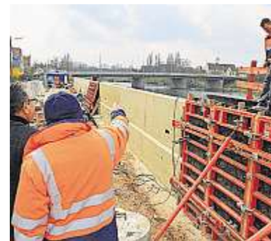
Die Hochwasser-Schutzmauer soll 1,20 Meter über den Boden ragen
