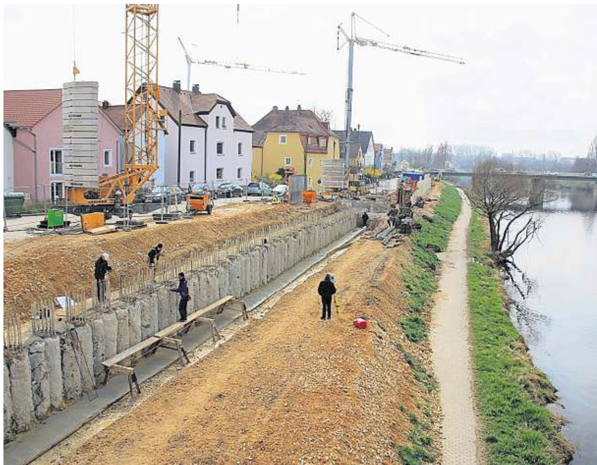
Am Hochwasserschutz am Unteren Regenufer wird derzeit fleißig gewerkelt.
