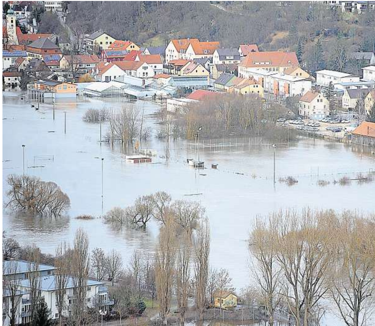
Die Sallerner Sportplätze sollen auch nach dem Bau des HW100-Hochwasserschutzes als Überschwemmungsflächen dienen.
