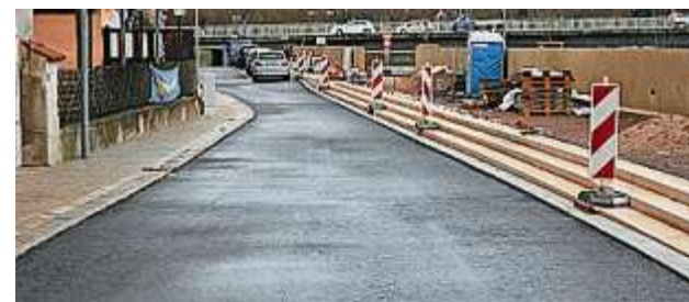
Der Straßenbelag in der Unterer Regenstraße ist fertig.
