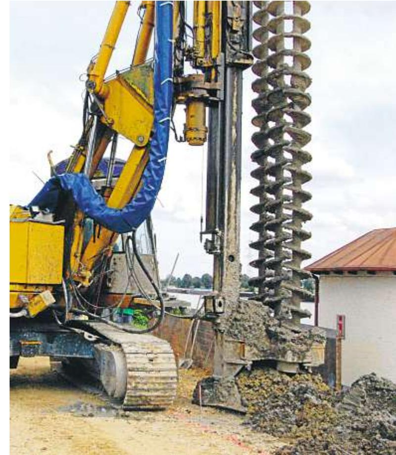
Das MIP-Verfahren: Bohren und Verfüllen gleichzeitig
