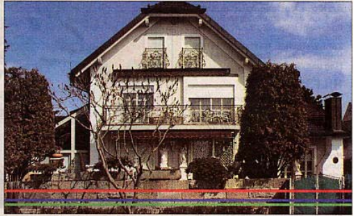
Am Schwabelweiser Donauufer 27 stellt sich die Situation wieder ganz anders dar: Selbst von einem hundertjährigen Hochwasser wäre das Anwesen kaum bedroht. Fotos: Tiefbauamt
