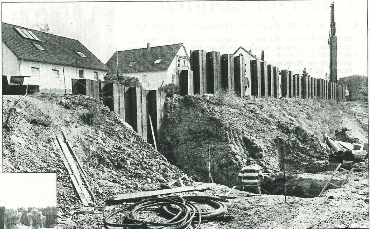
Bis zu zwölf Meter wird die Spundwand aus Stahl in die Erde gerammt.
