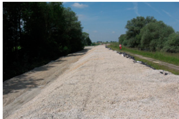
Abb. 4-3: Ruckasing, Gde. Osterhofen, Deichverteidigung durch Erhöhung der Deichkrone beziehungsweise Auflastschüttungen
