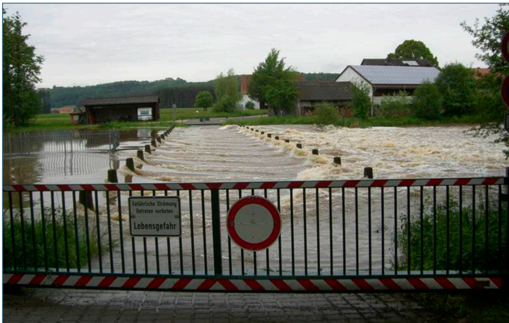
Abb. 3-2: Altmühlüberleitung am Hühnermühlendamm
