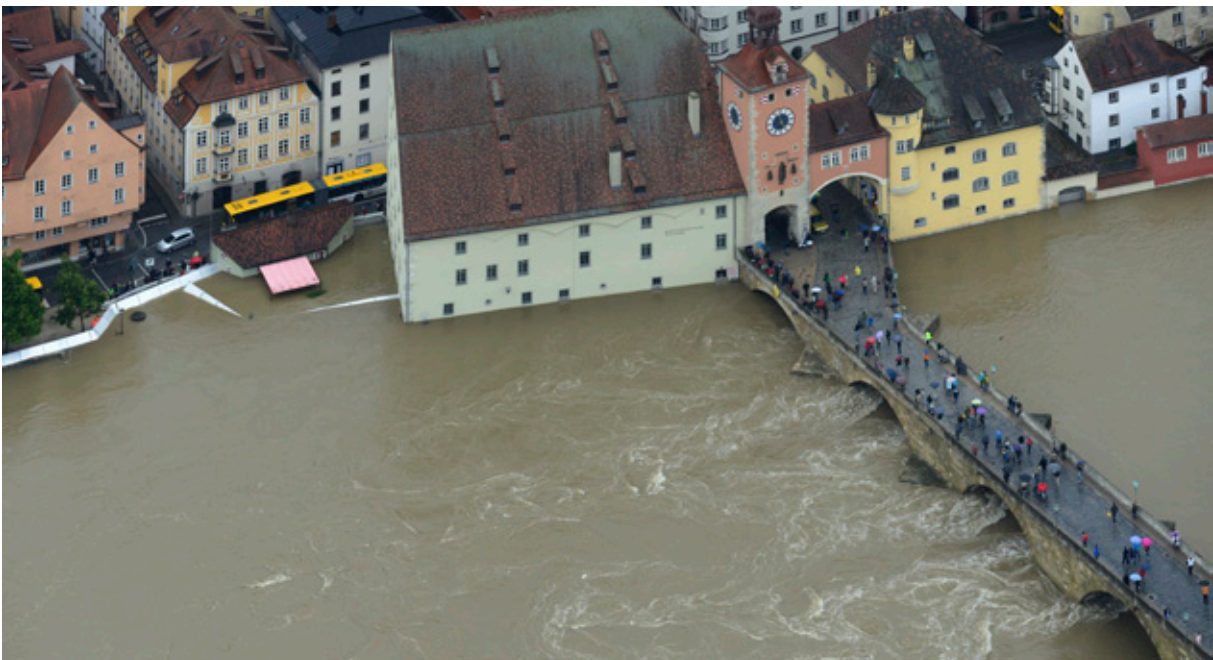
Abb. 4-2: Regensburg, Einsatz der Notfallsysteme
