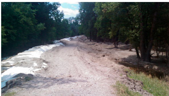
Abb. 4-4: Deichbruch Isar, Bruchstelle und Schadensbeseitigung nach dem Hochwasser 2013
