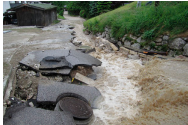
Abb. 5-5: verlegte Verrohrung am Bergbach
