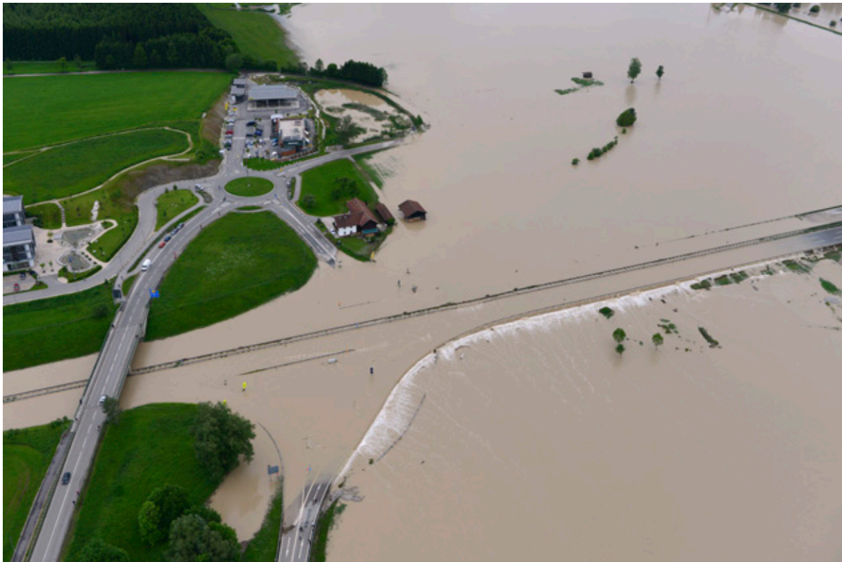
Abb. 4-9: Überflutung der Bundesautobahn A8, Anschlussstelle Grabenstätt
