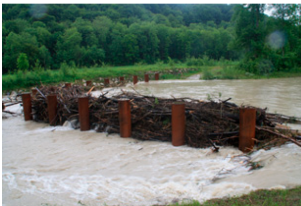
Abb. 5-3: Erfolgreiche Schutzmaßnahmen an Wildbächen beim Hochwasser Juni 2013: links: Schwemmholzrechen an der Leitzach; rechts: Prien in der Gemeinde Aschau.
