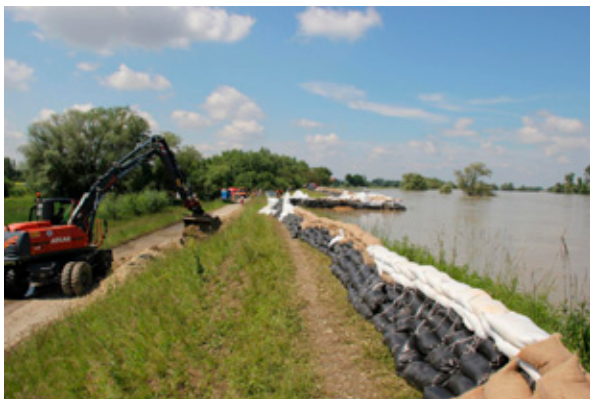
Abb. 4-3: Ruckasing, Gde. Osterhofen, Deichverteidigung durch Erhöhung der Deichkrone beziehungsweise Auflastschüttungen
