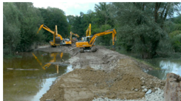
Abb. 4-4: Deichbruch Isar, Bruchstelle und Schadensbeseitigung nach dem Hochwasser 2013
