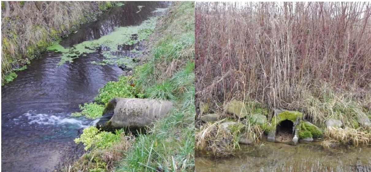
Abbildung 3.7 Einleitung des Drainagewassers in den Niederwinzerer Graben (links) und in den Winzerer Graben (rechts)
