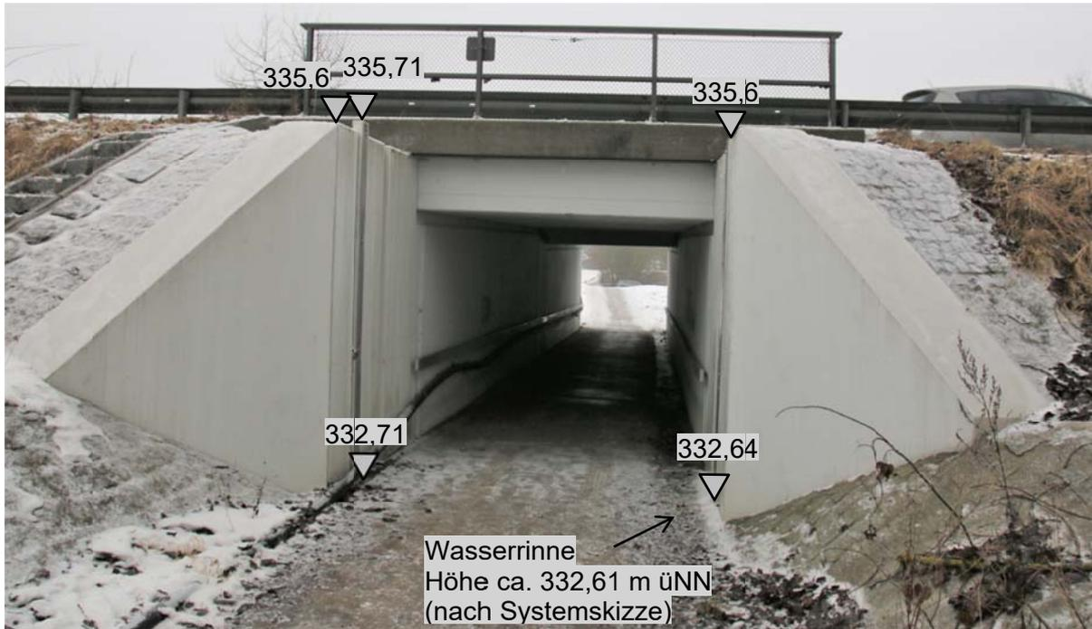
Abbildung 3.8 Feldwegunterführung bei Fkm 2.383, Blick von Süden, Höhenangaben nach GPS Vermessung vom 11.01.2018 (Genauigkeit von 2 bis 3 cm)
