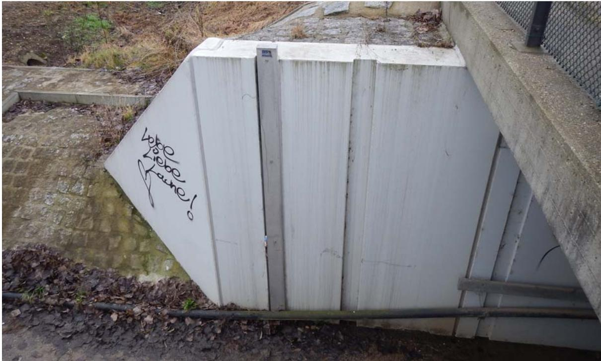
Abbildung 3.10 Dammbalkenverschluss an der Feldwegunterföhrung bei Fkm 2.383
