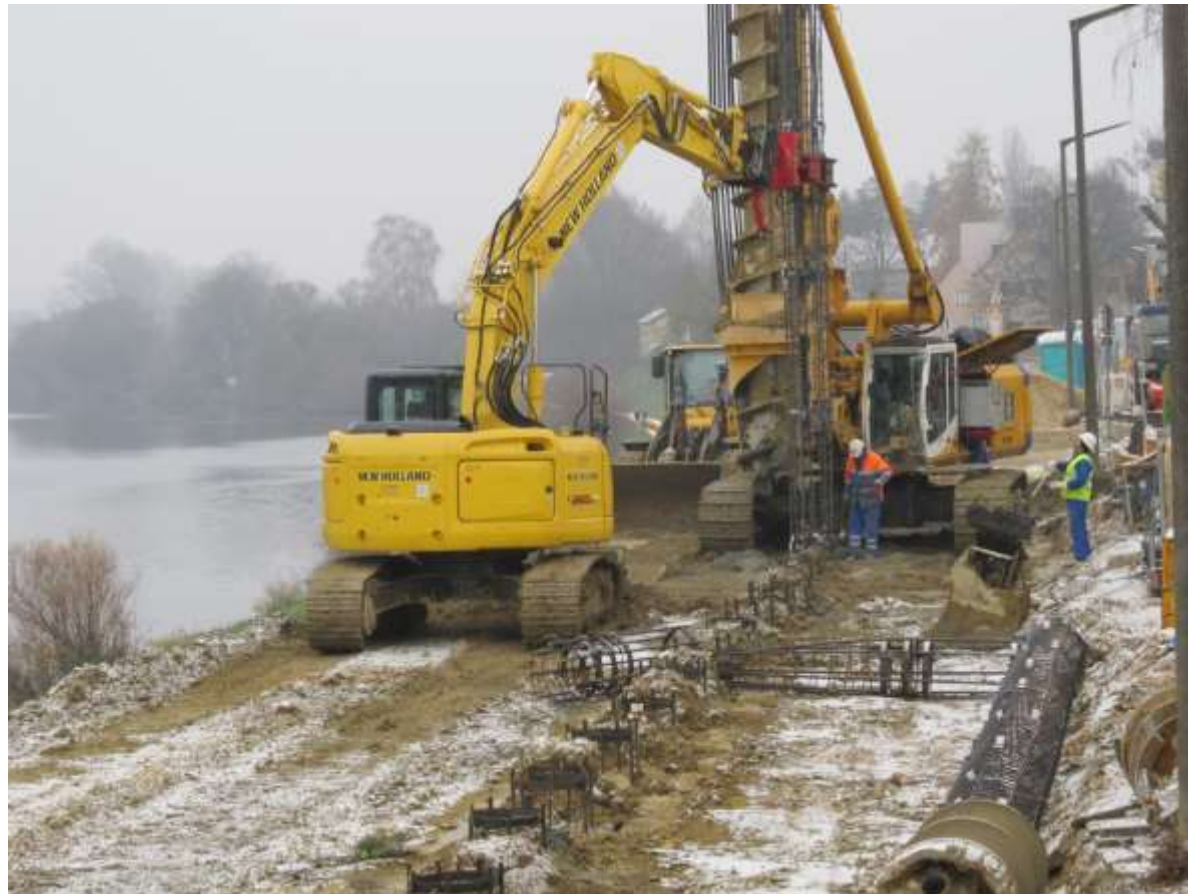
5.: Eindrücken der Stahlkörbe in den noch weichen Beton
