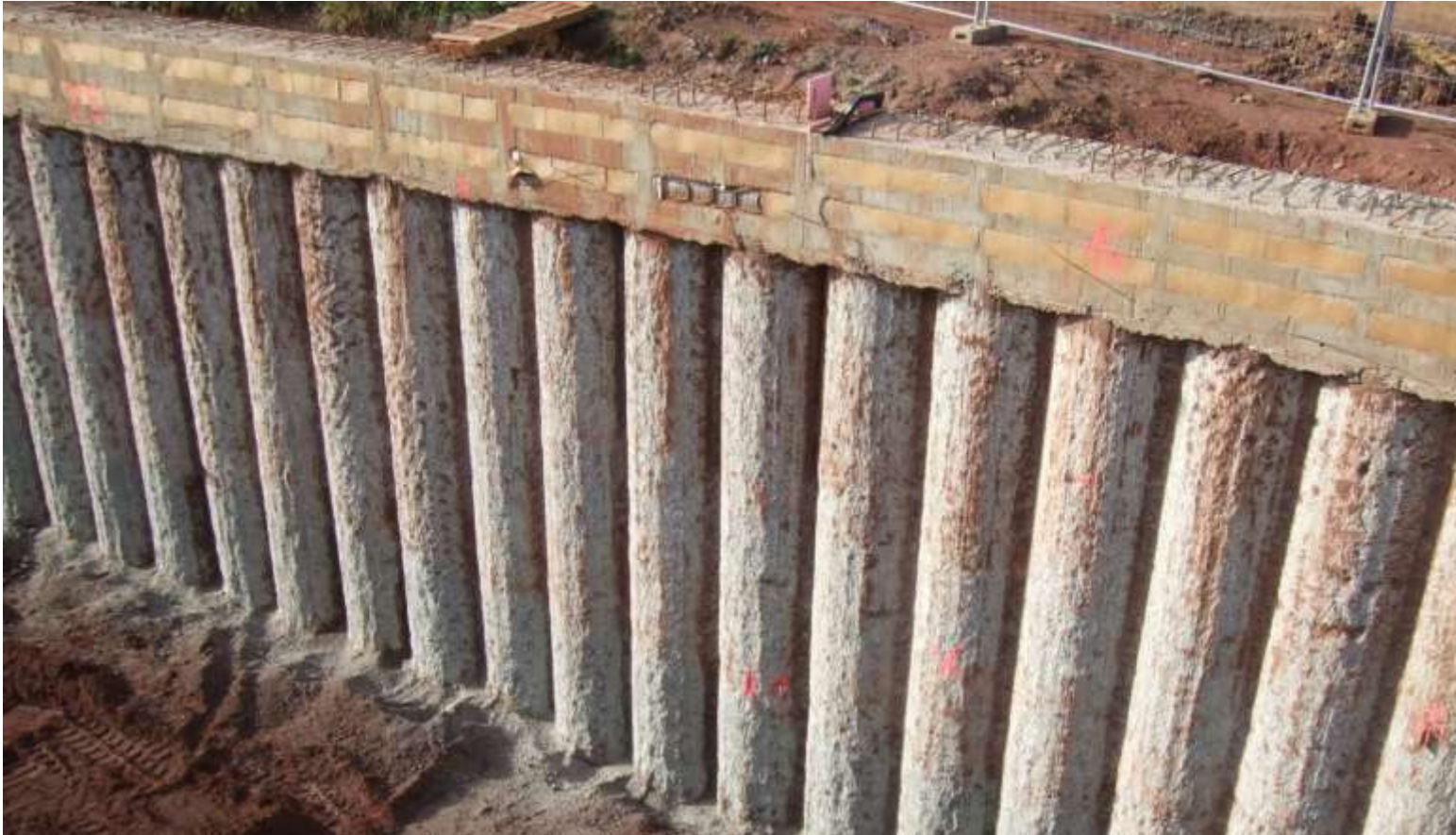
Bohrpfähle mit Kopfbalken
