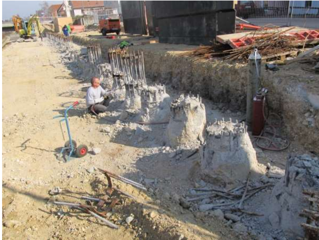
6.: Abstemmen der obersten Schicht der Pfähle
