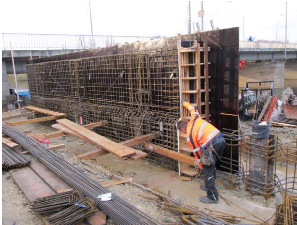
7.: Flechten der Bewehrung und Anbringen der Schalung
