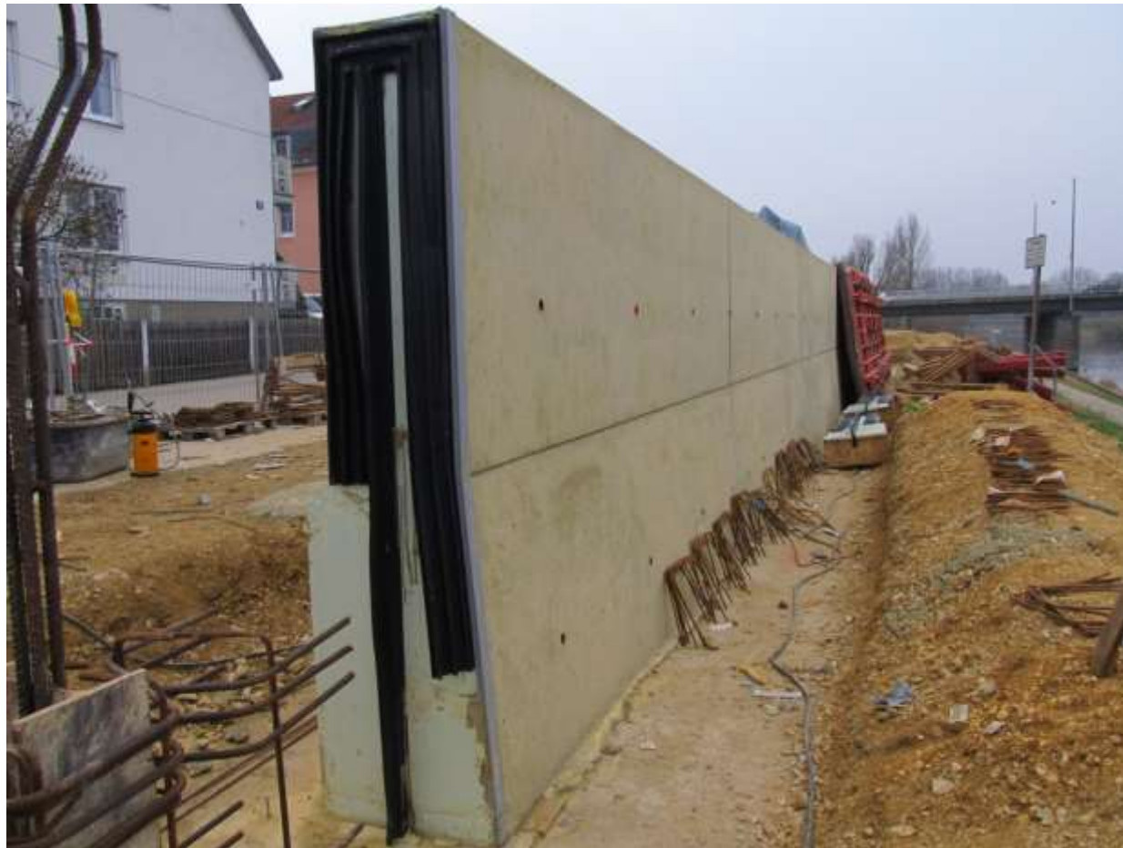
8.: Fertiger Mauerabschnitt mit Blick auf die Dichtung an der Dehnfuge
