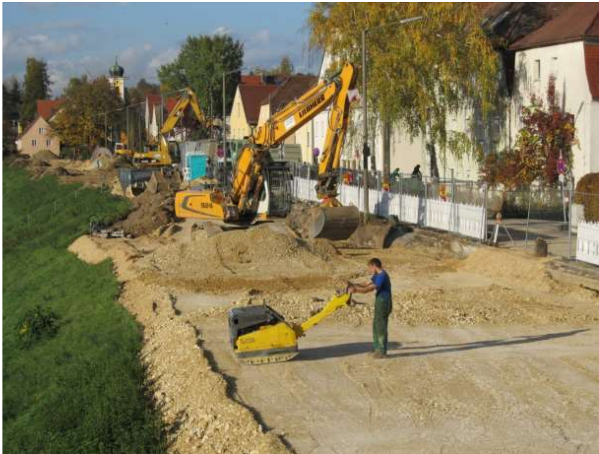
1.: Einrichten einer Baustraße
