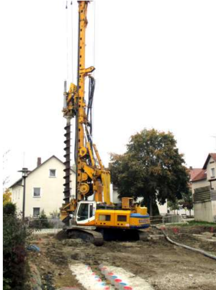
3.: Bohren und Betonieren der Pfähle
