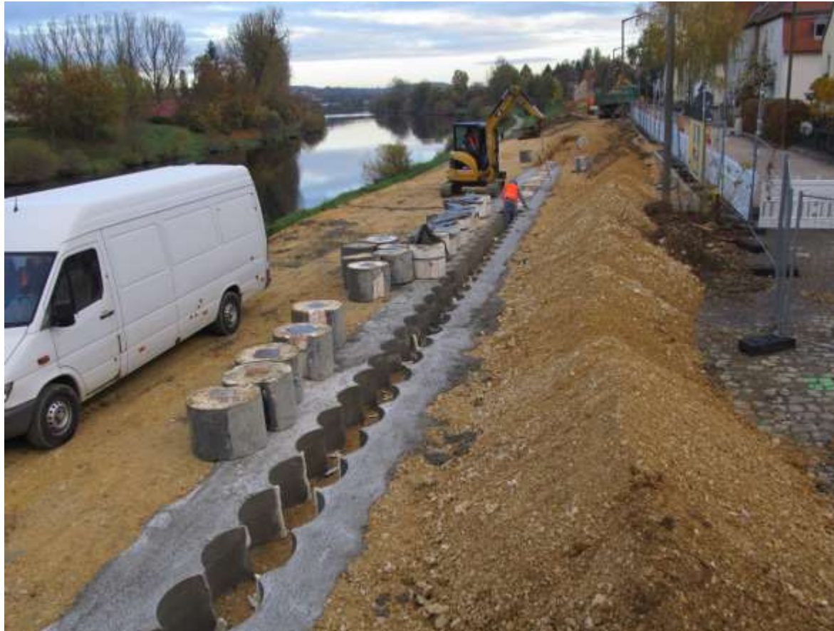
2.: Bohrschablonen aus Beton
