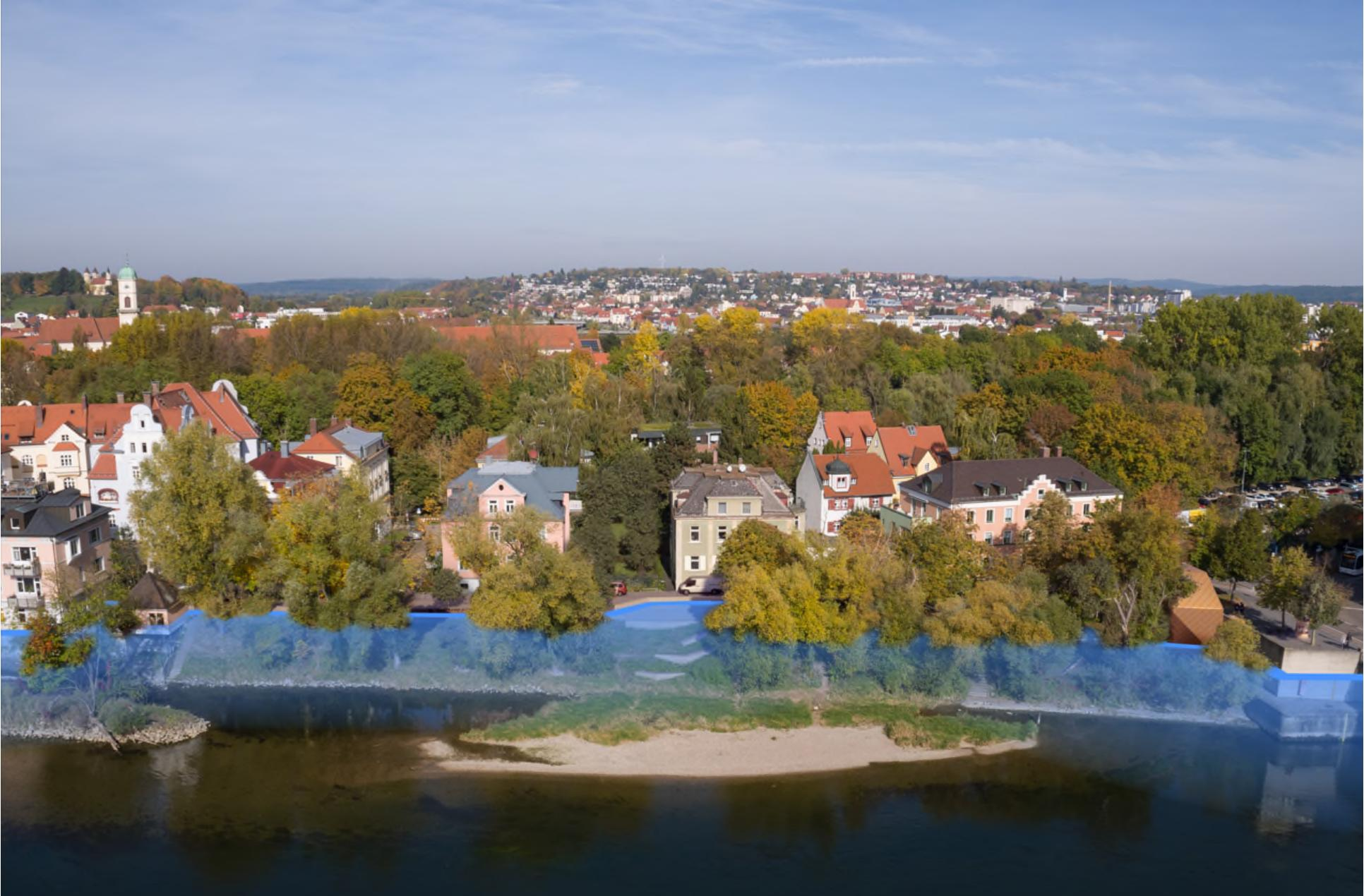
**mit aufgebautem HWS und Wasserlinie HW100**
