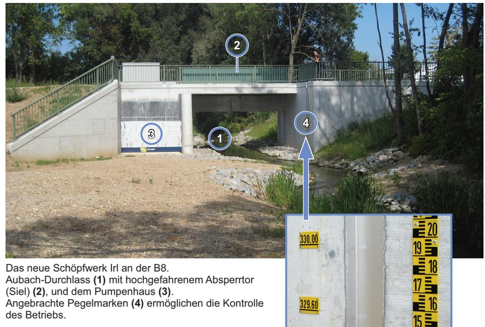
Das neue Schöpfwerk Irl an der B8. Aubach-Durchlass (1) mit hochgefahrenem Absperrtor (Siel) (2), und dem Pumpenhaus (3). Angebrachte Pegelmarken (4) ermöglichen die Kontrolle des Betriebs.
