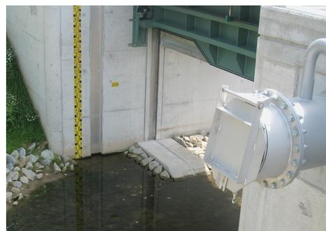
Pumpenauslauf und Absperrtor (Siel)
